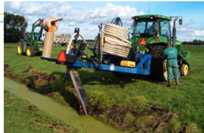
Onder-water drainage/ Hoog water/ greppel infiltratie
